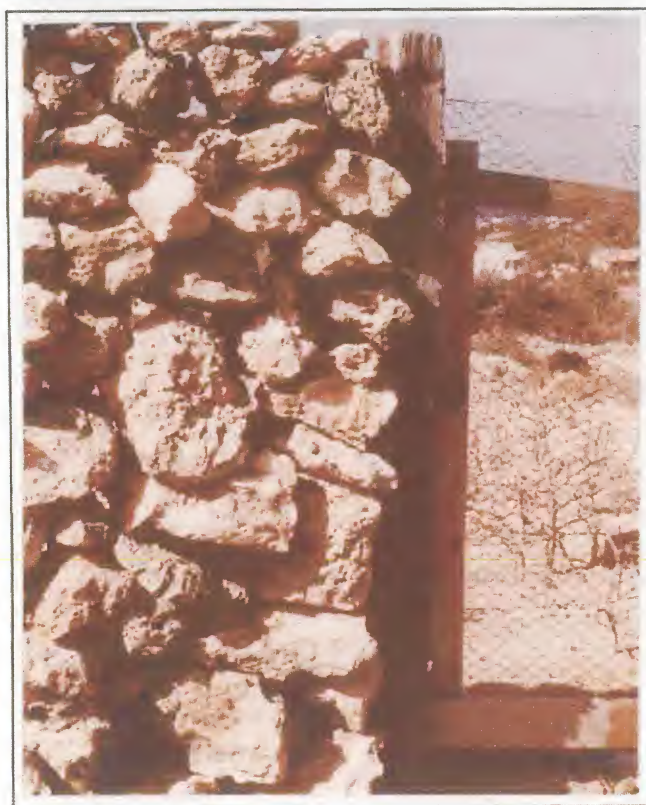
Foto 3.7. 1985 Een omheining, opgebouwd uit natuursteenbrokken. De muur sluit aan op een, in de grond geplaatste, paal waar een hekwerk aan bevestigd is.
